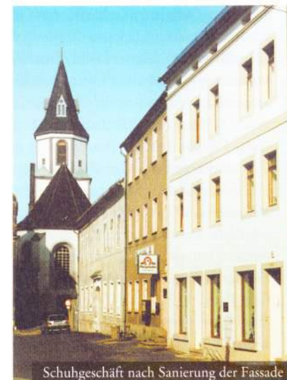
Schuhgeschäft nach Sanierung der Fassade
